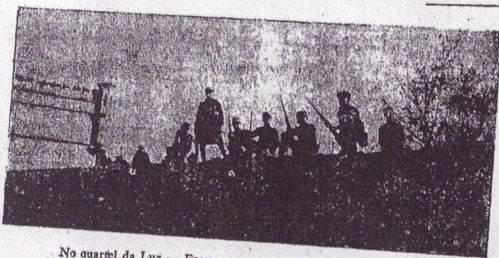
No quartel da Luz — Forças em observação no telhado do quartel
